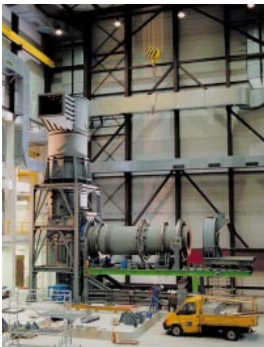
Abb. 3: THERESA – Aufbau Drehrohrofen (rechts) und Nachbrennkammer (Stand März 1999).
