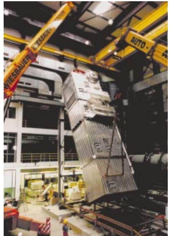
Abb. 4: THERESA – Aufbau des fast 50 Tonnen schweren Abhitze-Kessels (21. April 1999).
