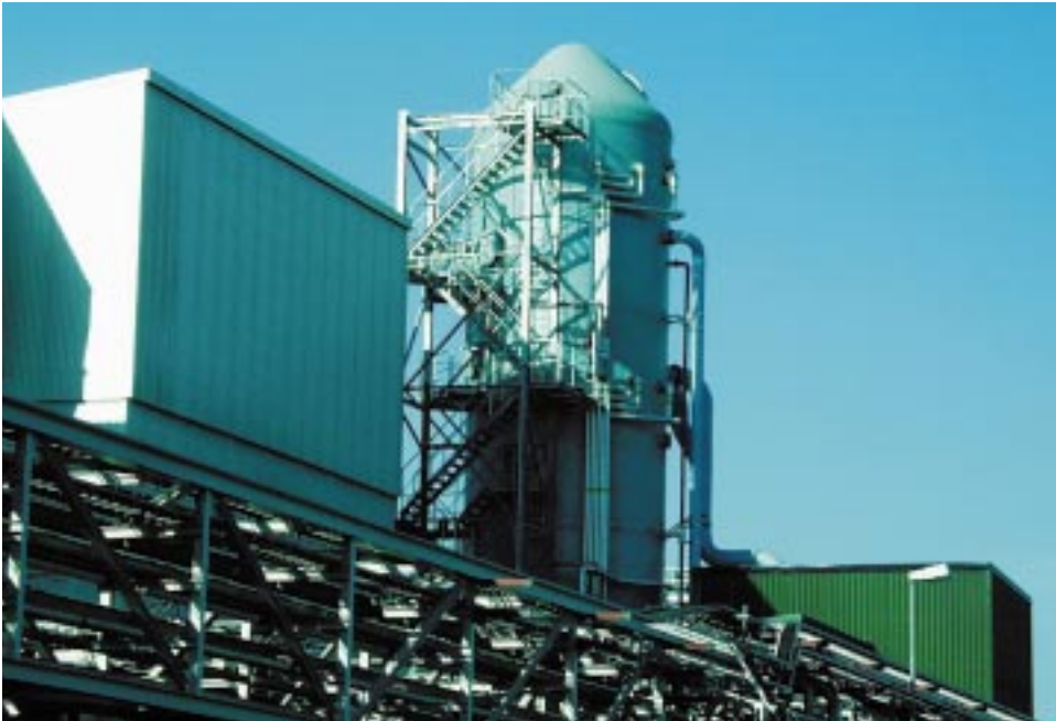
Abb. 7: MercOx-Verfahren als Endstufe der Rauchgasreinigung einer Sonderabfallverbrennungsanlage.
