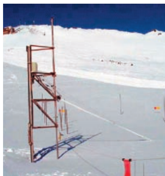
Abb. 4. Installation des TAUPE-Sensors für die Bestimmung von Schneefeuchte, Schneedicke und Schneewasseräquivalent (Messfeld Weissfluhjoch, Davos (CH)) zwischen einem Bodenanker und dem Turm. Die obere Befestigung muss höher liegen, als die maximal zu erwartende Schneedecke.
