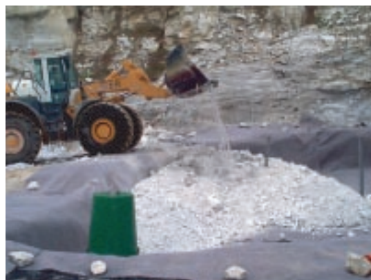
Abb. 5: Aufbau eines Großversuches in einem offengelassenen Steinbruch.
