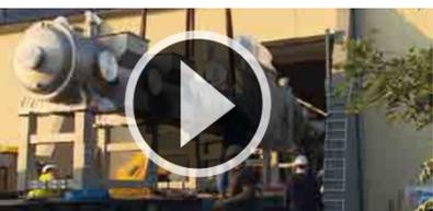
Ankunft des 25 Tonnen schweren und 16 Meter langen Kryostat- und Magnet-systems für die Tritiumquelle
