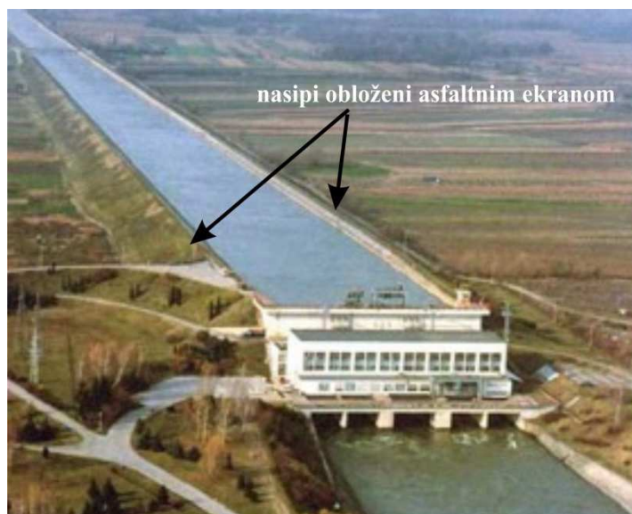
Slika 9.8 Dovodni kanal HE Varaždin, obložen asfaltnim ekranom
