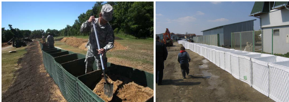
Slika 8.7 Obrana od poplave, svibanj 2011. Luisiana, USA, i gabioni u pripremi (L. Tadić)
