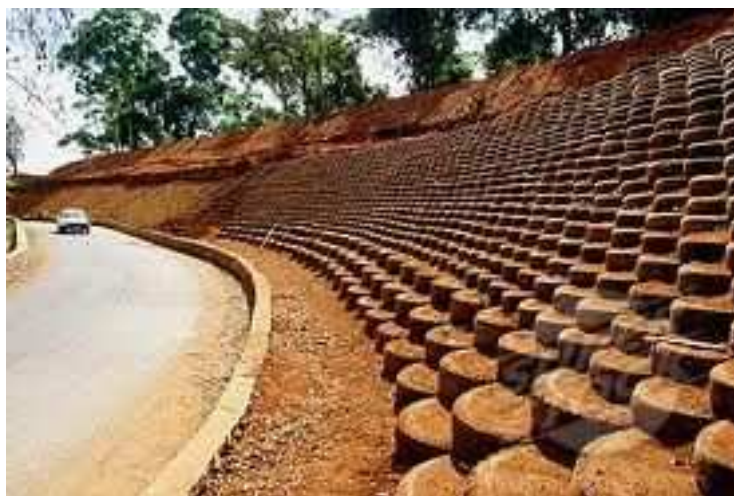
Slika 9.6 Nasip dijelom izveden od iskorištenih automobilskih guma
