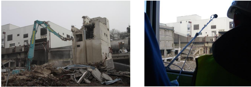
Abbildung 17: Messungen auf der Abbruchbaustelle in Köln im Rahmen der Phase 1
