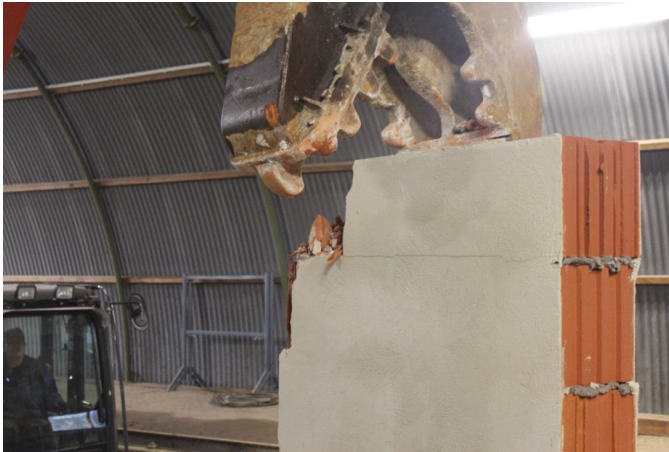
Abbildung 45: Zweite Versuchsreihe: Abbruch von verputzten Ziegelsteinwänden
