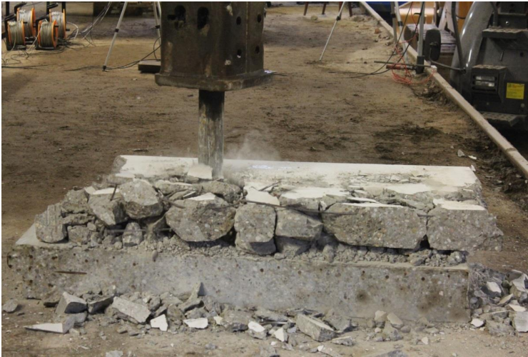
Abbildung 46: Dritte Versuchsreihe: Abbruch von Stahlbetonteilen
