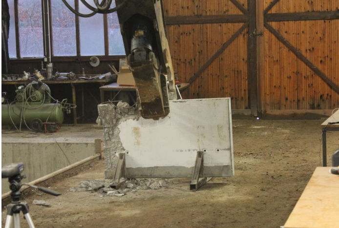
Abbildung 48: Dritte Versuchsreihe: Pressschneiden von Stahlbeton
