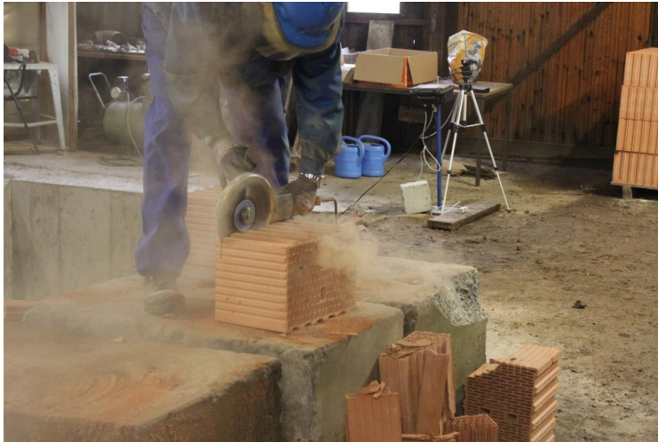
Abbildung 47: Erste Versuchsreihe: Sägen von Ziegelmauerwerk
