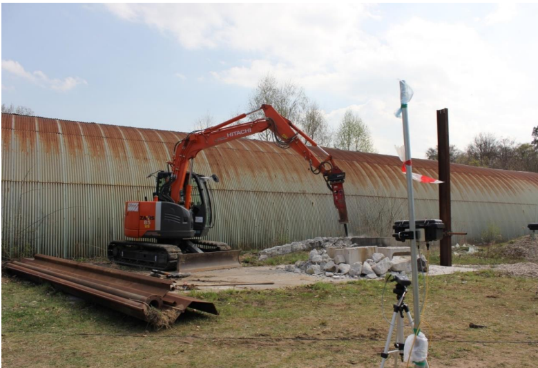
Abbildung 28: Versuchsreihe mit Hydraulikbagger und Immissionserfassungssystem (rechts)
