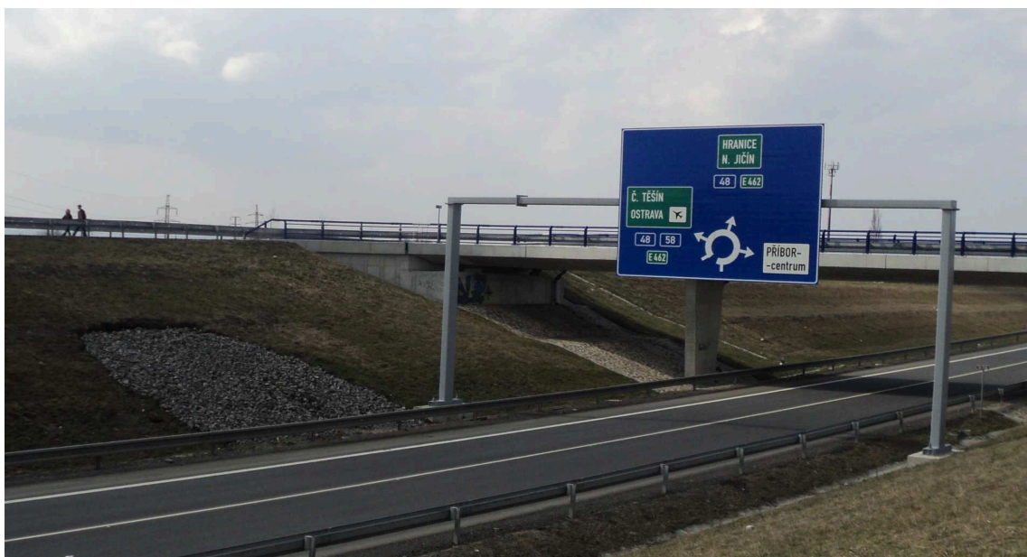
Obrázek 12: Sanace sesuvu svahu zářezu, vlastní foto pořízeno dne 14.4.2013
