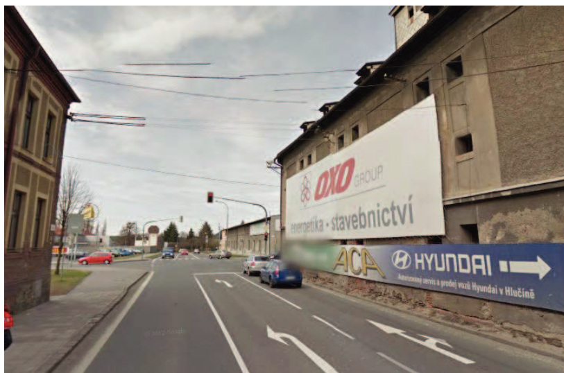
Obr. 2-2: Fotografie silnice I/56 na průtahu městem Hlučín [2]
