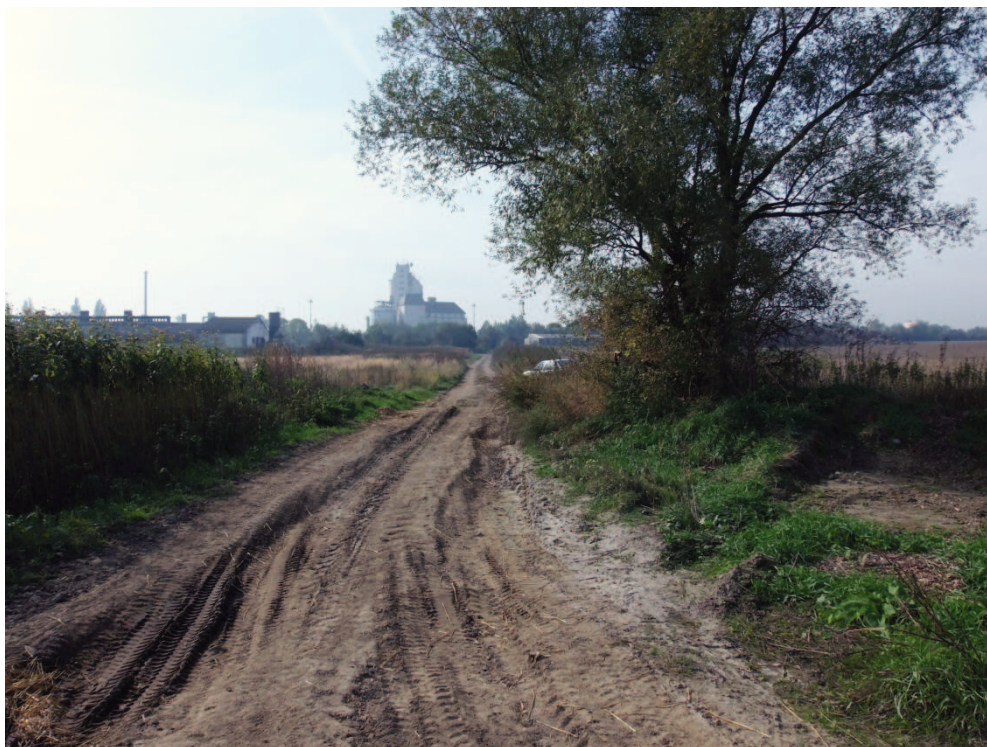
Obr. 10-5 Pohled na účelovou komunikaci
