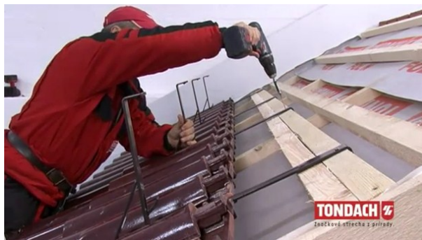
Obr. Montáž držáků pro sněhovou mříž [42]
