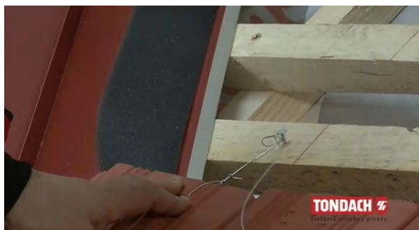
Obr. samolepicí těsnicí pás a přichytka malých průřezů tašek drátem [38]
