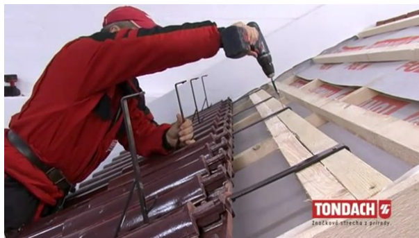
Obr. Montáž držáků pro sněhovou mříž [42]
