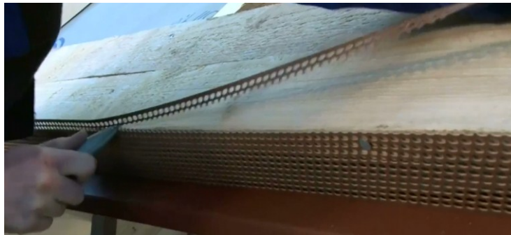
Obr. Přichycení a úprava hliníkového ochranného pásu OVP [51]
