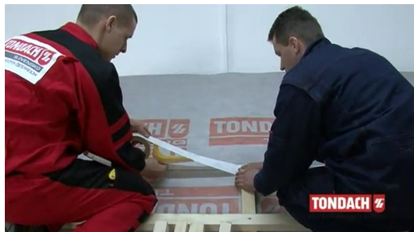
Obr. Kladení pojistné hydroizolace [33]
