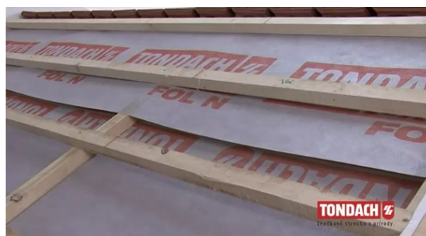
Obr. Kladení pojistné hydroizolace u hřebene střechy [37]
