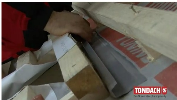
Obr. Odvodňovací žlabek nad střešním oknem [43]
