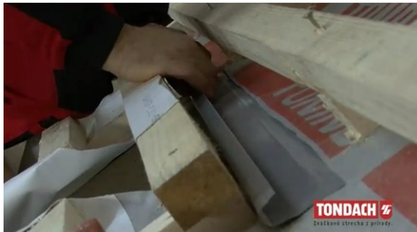
Obr. Odvodňovací žlábek nad střešním oknem [43]
