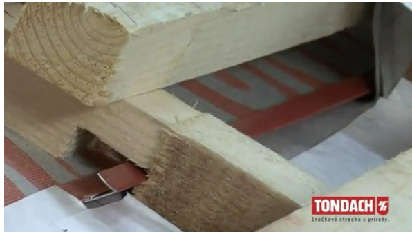
Obr. Odvodňovací žlab u zlomu pultového vikýře [39]
