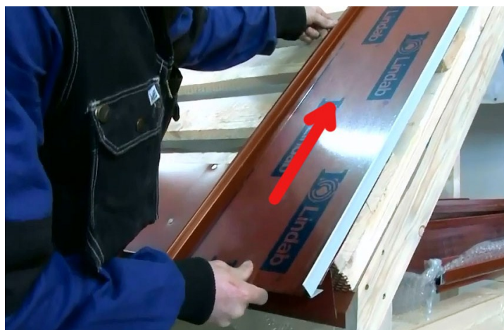
Obr. Montáž prvního pásu [51]
