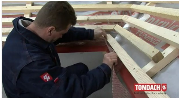
Obr. Přichycení hliníkového ochranného pásu“ [33]
