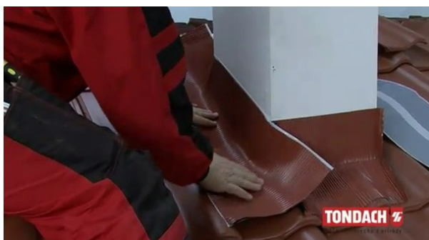
Obr. Úprava bočního těsnícího pásu [39]
