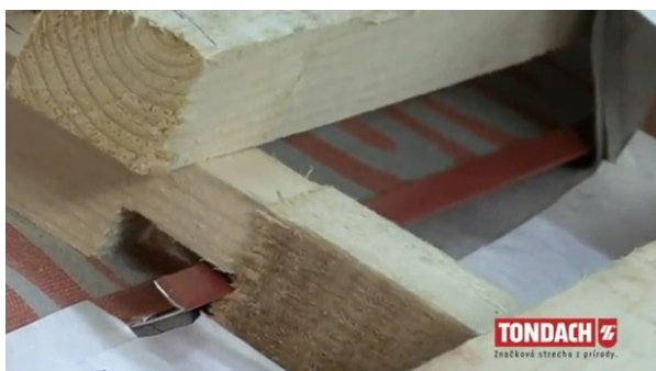
Obr. Odvodňovací žlab u zlomu pultového vikýře [39]
