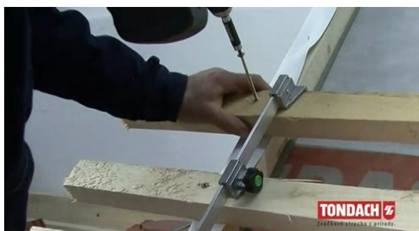
Obr. Nanášení vzdálenosti latí pomocí nářadí „koník“ [34]
