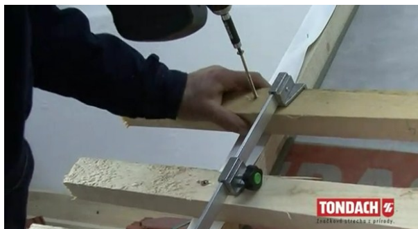
Obr. Nanášení vzdálenosti latí pomocí nářadí „koník“ [34]
