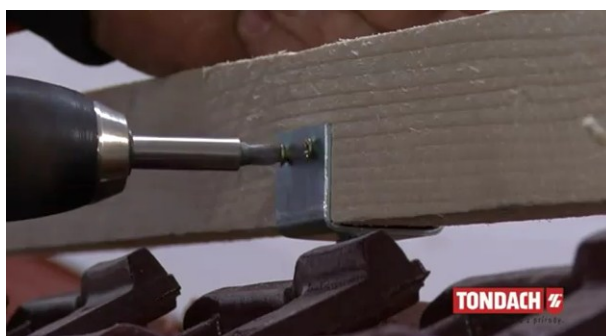
Obr. Přichycení hřebenové latě [37]
