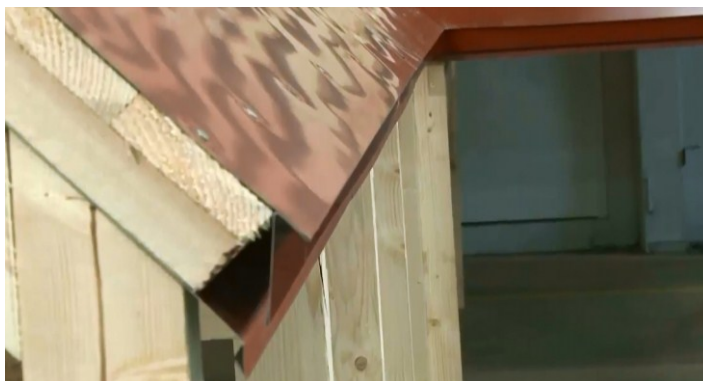
Obr. Zatahovací okapový plech – startovací profil pro krytinu Lindab CLICK [51]
