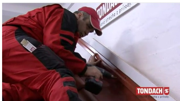
Obr. montáž těsnící lišty [36]
