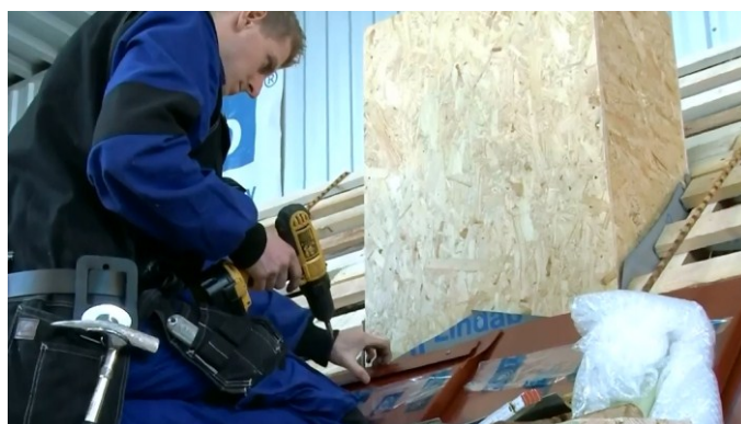
Obr. Montáž napojovací lišty [51]
