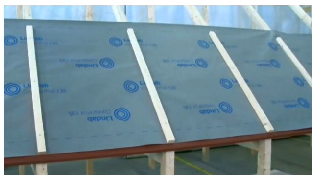
Obr. Montáž kontratátí [51]
