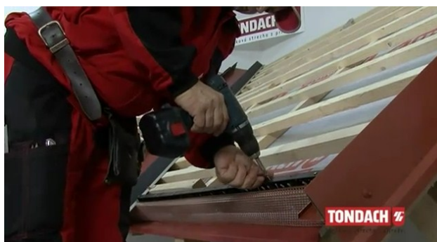
Obr. Osazování ochranné větrací mřížky [33]
