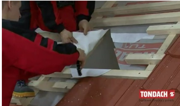
Obr. Úprava fólie před montáží střešního okna [43]
