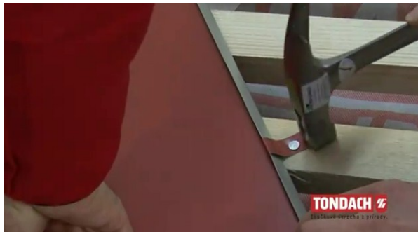
Obr. Správné přichycení úžlabí přichytkami [38]
