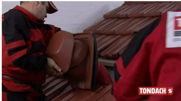
Obr. Usazení prostupového kompletu [41]
