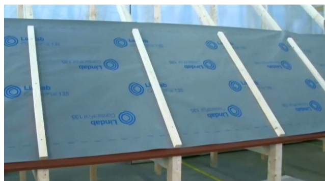
Obr. Montáž kontralatí [51]
