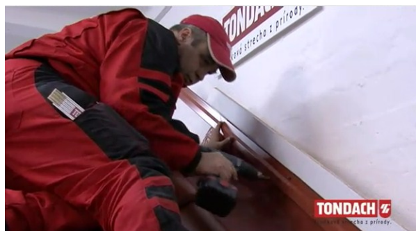
Obr. montáž těsnící lišty [36]
