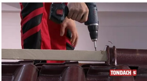
Obr. Uchycení hřebenáče pomocí přichytky [37]
