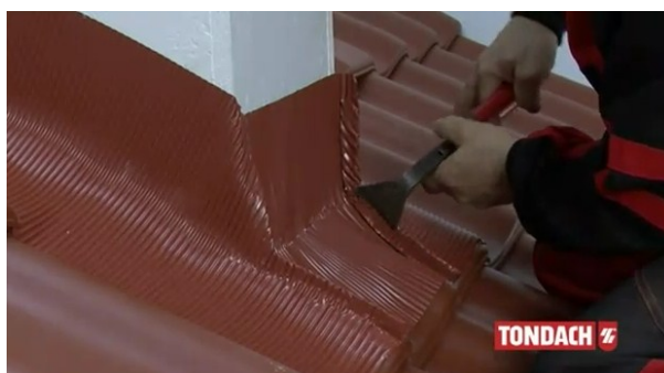
Obr. Zahnutí těsnících pásů [39]
