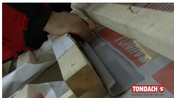
Obr. Odvodňovací žlábek nad střešním oknem [43]
