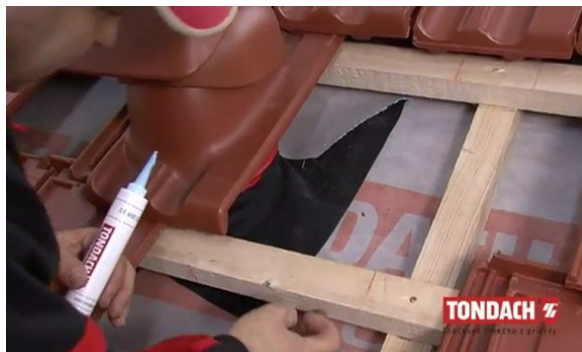
Obr. Použití těsnícího tmele [41]
