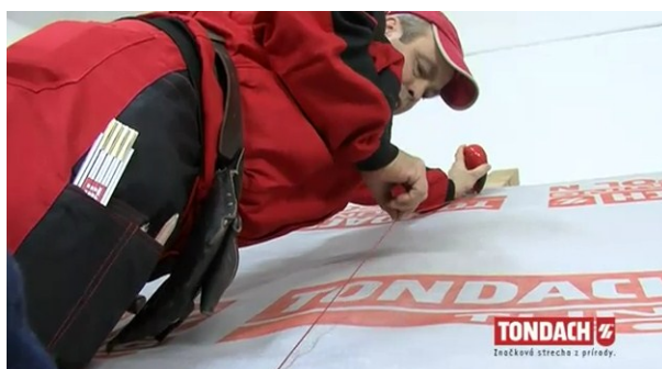
Obr. Vyznačení středu krokví pomocí šňůrovačky [33]
