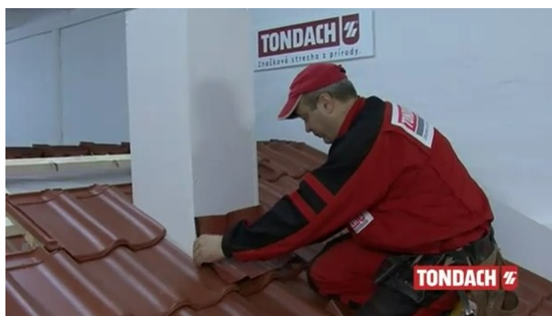
Obr. Úprava těsnícího pásu [39]
