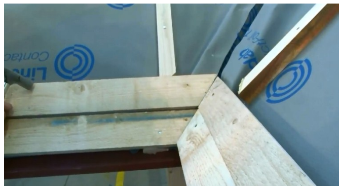
Obr. Kladení okapové latě [51]
