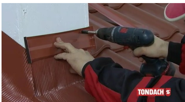
Obr. Překrytí těsnícího pásu pomocí hliníkové lišty [39]
