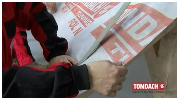
Obr. lepení těsnicí pásky TONDACH TUNING 60 pod kontralatě [33]
