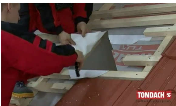
Obr. Úprava fólie před montáží střešního okna [43]
