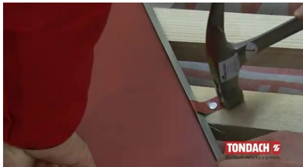
Obr. Správné přichycení úžlabí přichytkami [38]
