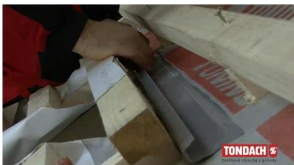
Obr. Odvodňovací žlábek nad střešním oknem [43]
