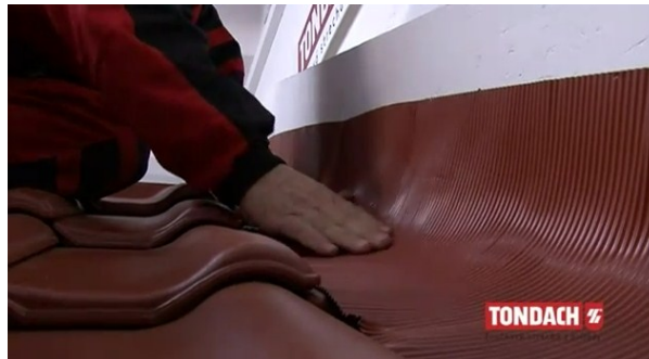
Obr. napojení na zeď hliníkovým pásem [36]
