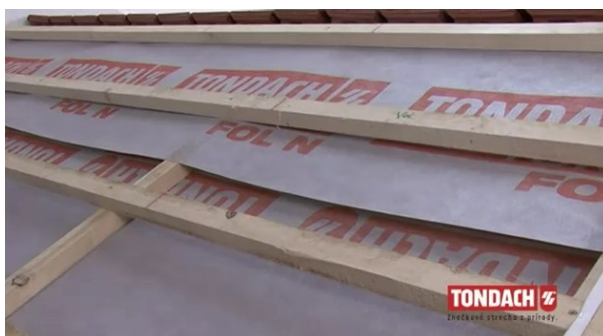
Obr. Kladení pojistné hydroizolace u hřebene střechy [37]
