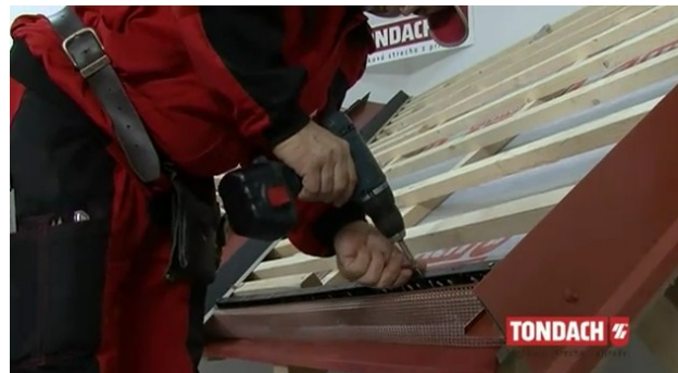
Obr. Osazování ochranné větrací mřížky [33]
