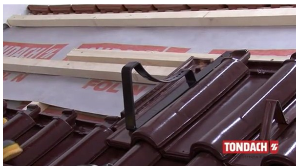
Obr. Montáž držáků stoupacího kompletu [40]
