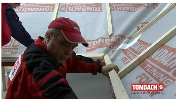
Obr. Kladení okapová latě [33]
