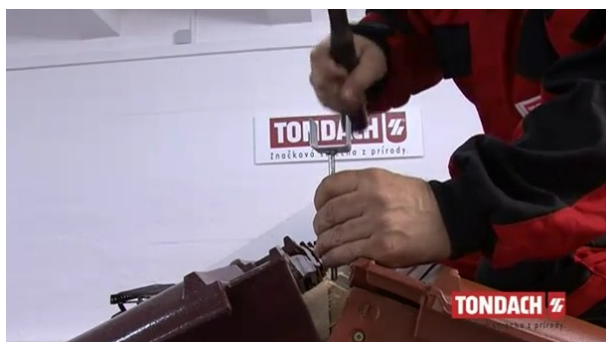
Obr. Montáž hřebenové latě [37]
