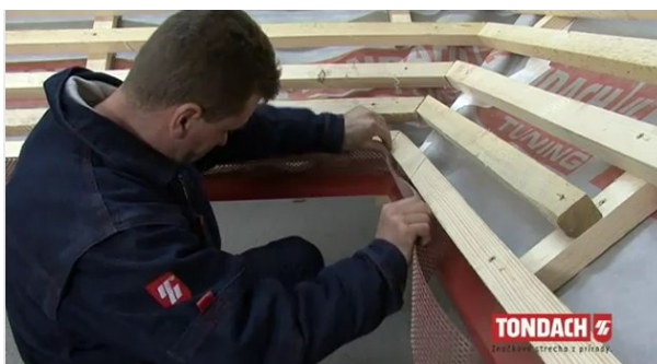
Obr. Přichycení hliníkového ochranného pásu“ [33]
