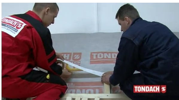
Obr. Kladení pojistné hydroizolace [33]
