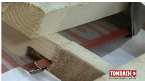
Obr. Odvodňovací žlab z plechu nad komínem [39]
