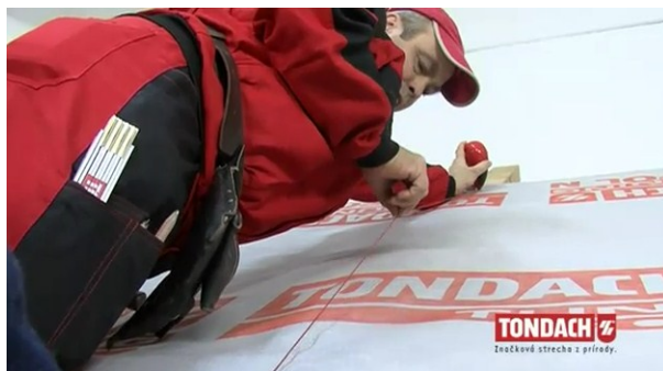
Obr. Vyznačení středu krokví pomocí šňůrovačky [33]
