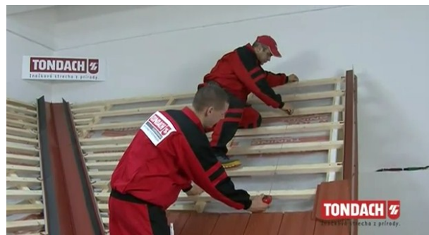
Obr. Nanesení krycí šířky pomocí šňůrovačky [35]
