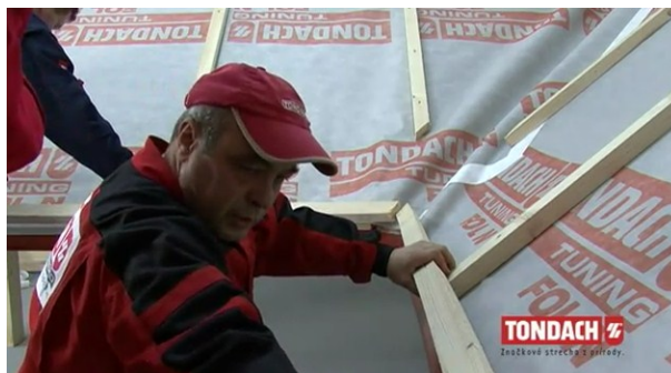
Obr. Kladení okapové latě [33]
