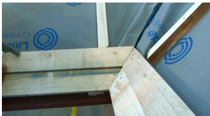
Obr. Kladení okapové latě [51]
