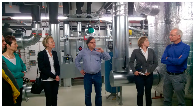
Bild 3: Führung durch den Technikbereich, mit Abwärmespeicher rechts.
