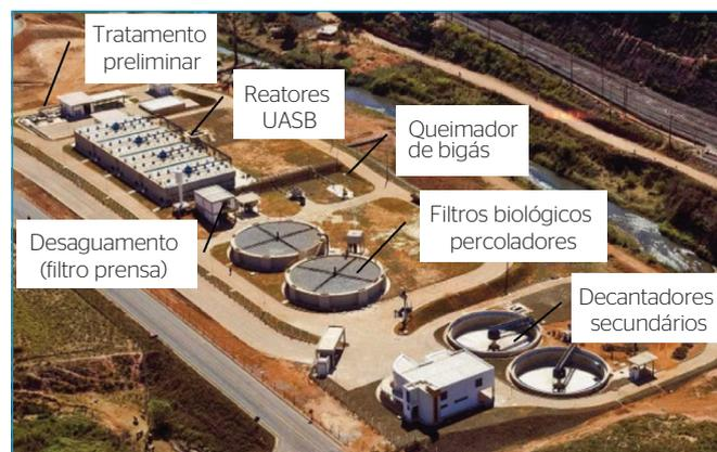
Figura 1 - Vista geral das unidades da estação de tratamento de esgoto *Laboreaux*.
