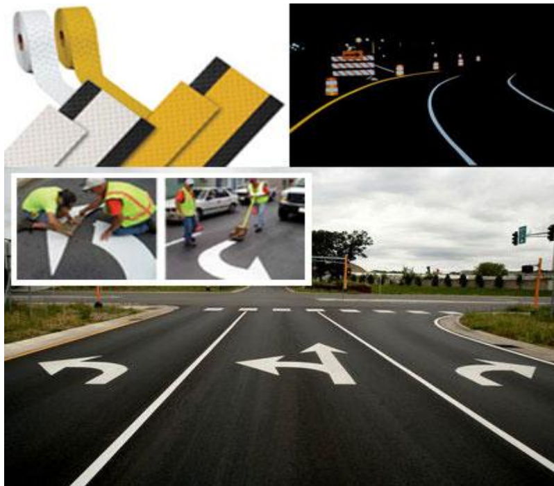
Slika 10. Oznake od trake i načini postavljanja
