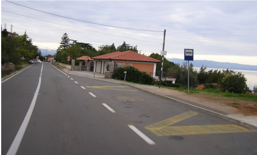
Slika 16. Autobusno stajalište izvan kolnika, [22]
