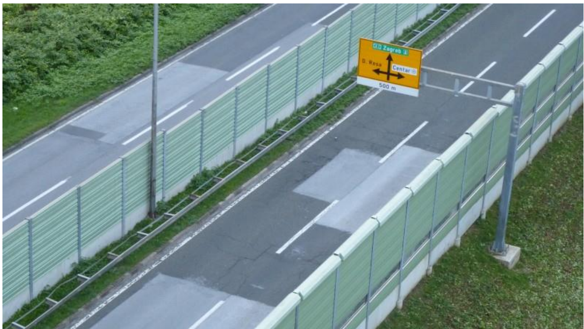
Slika 12: Uređaj za zaštitu od buke na autocesti
