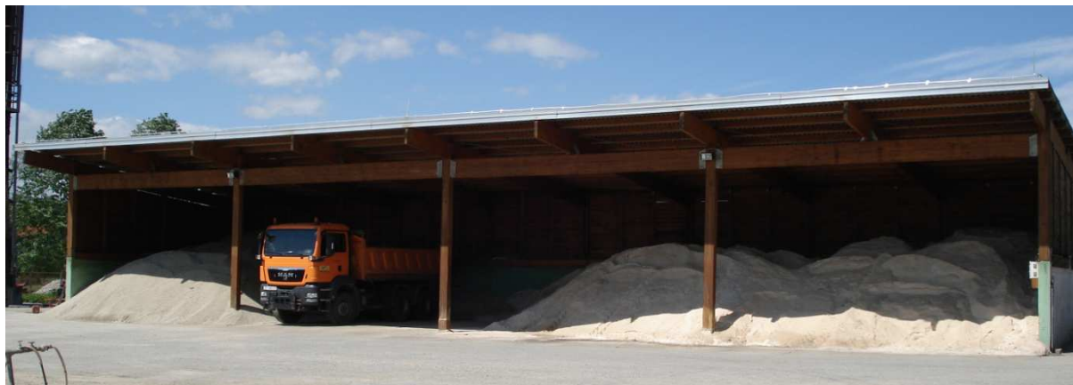
Slika 6.2.3. Skladište kamene sitneži i rinfuzne soli
