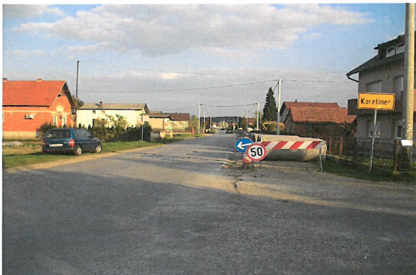
Slika 5. Radovi na županijskoj cesti 2029 u mjestu Koretinec
