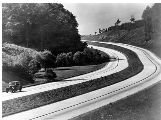
Slika 1. „Crne oznake” koje su izvedene na njemačkoj autocesti
