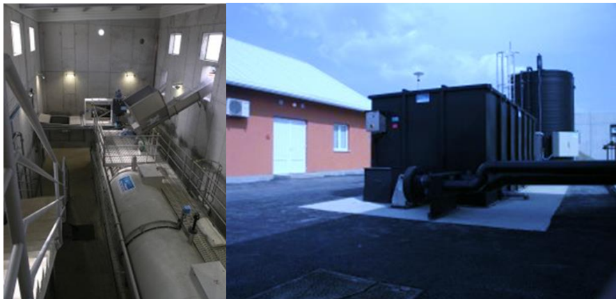
Slika 7. Biofilar za pročišćavanje zraka [11]
