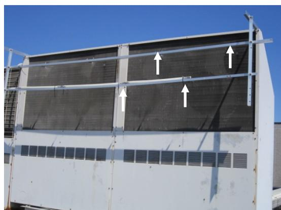
図1 散水ノズルの様子
