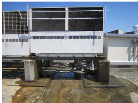
図2 散水中の室外機状況
