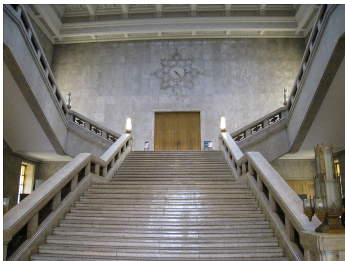
図8 東京国立博物館本館(上野) 正面階段手すりとホール壁面に使用された「時鳥」(阿南市阿瀬比町産)。1938(昭和13)年開館(帝冠様式:渡辺仁設計)。1881(明治14)年竣工,関東大震災で被災し,修復・再建の際に「時鳥」が用いられ,現在に至っている。
