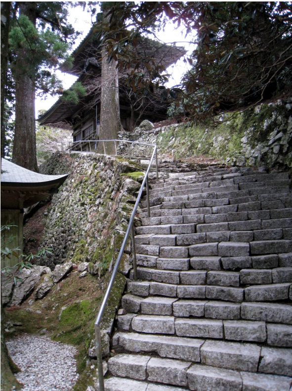
図2 四国八十八箇所霊場 21 番札所太龍寺の講堂から多宝塔への石段に使用された大理石。
