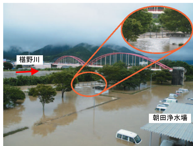
図 4-1 榎野川から朝田浄水場への越水状況 [3]
