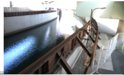
現在の仮設護岸 (2010年11月29日撮影)
