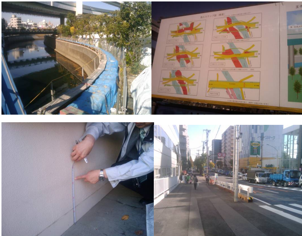
図 3-28 東京都北区 石神井川 溝田橋付近 現地写真
