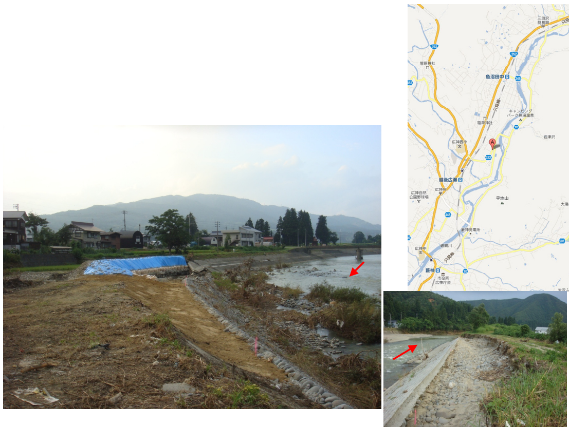
図 3-12 魚沼市（破間川）現地調査写真（1）
