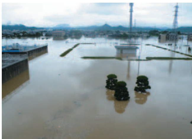
図 4-7 朝田浄水場の冠水状況（山口市） [3]
