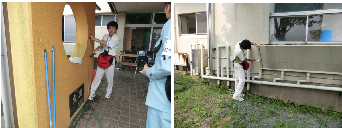
図 3-45 被災した養護老人ホーム（3）
