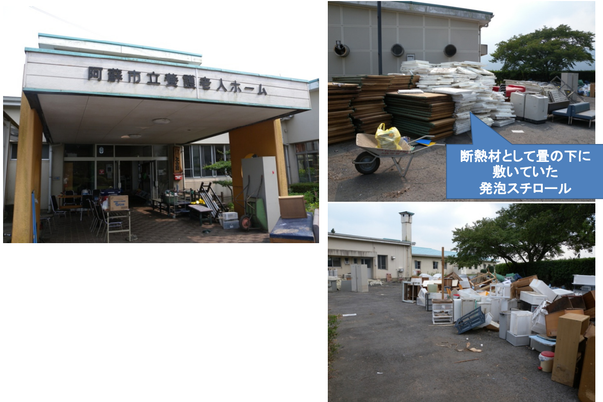
図 3-43 被災した養護老人ホーム（1）
