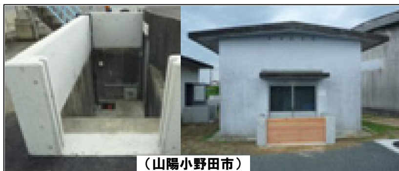
図 4-12 止水壁が設置された鴨庄浄水場 (現在) [6]
