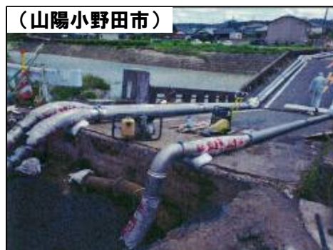
図 4-11 送水用仮設配管(新橋)
