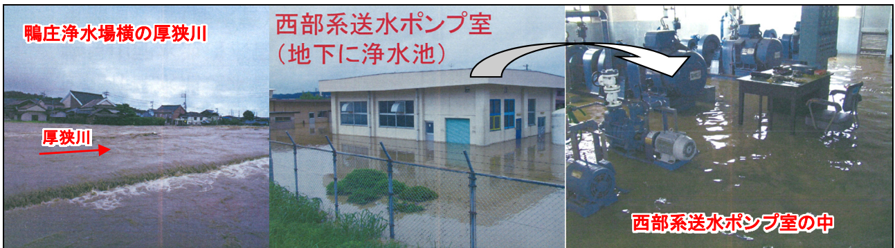
図 4-10 厚狭川の越流氾濫・鴨庄浄水場の冠水状況
