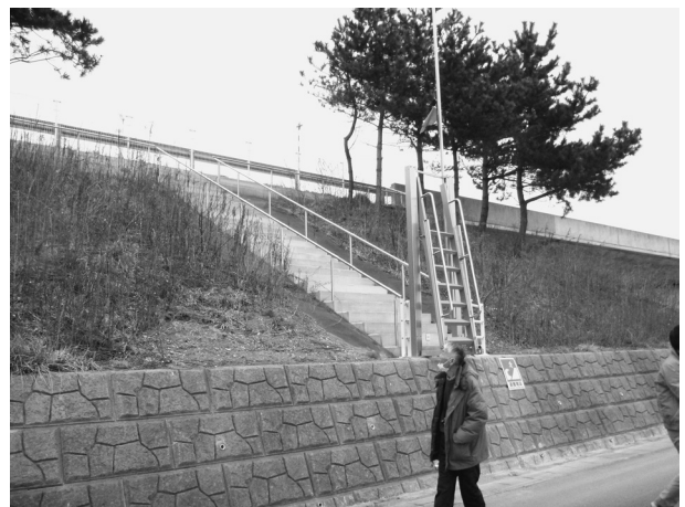
図8. 仙台東部道路に設けられた避難階段
