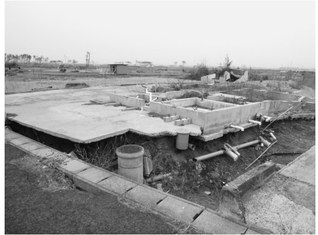
図 10. 基礎部分まで津波で浸食された住居跡
