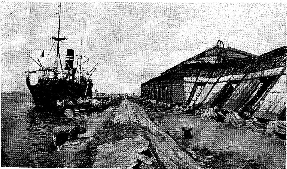
第九十五 横濱港第六號岸壁ノ推出及ピ上屋ノ倒壊
