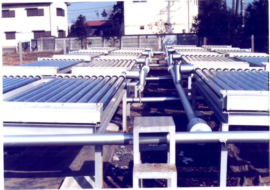
図 4-5 真空管式ソーラーコレクタ
