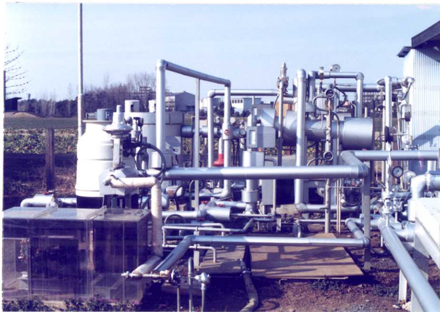
図 4-4 フロンランキンサイクルの部分
