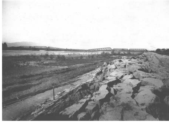
付図 26. 長良川鉄橋の全景
