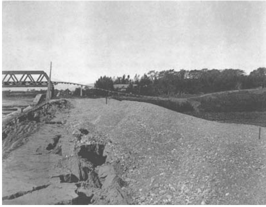
付図 25. 長良川鉄橋にかかるところ
