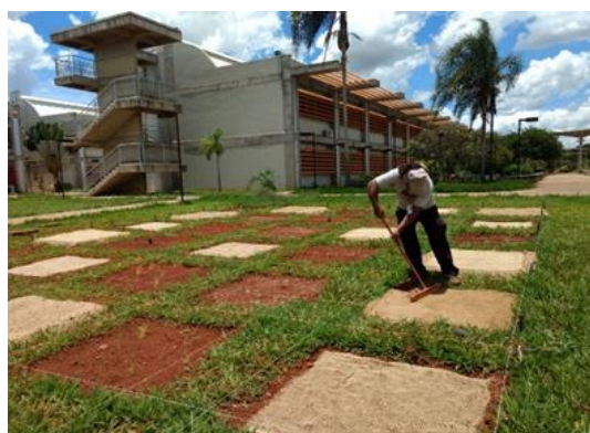
Figura 10. Aplicação da cobertura de areia, plantio e colocação da juta.
