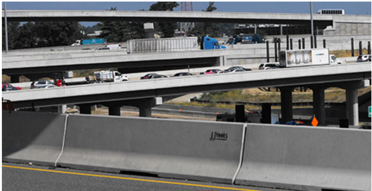
Figura 3.3 – Exemplo de Barreira Rígida em Concreto
