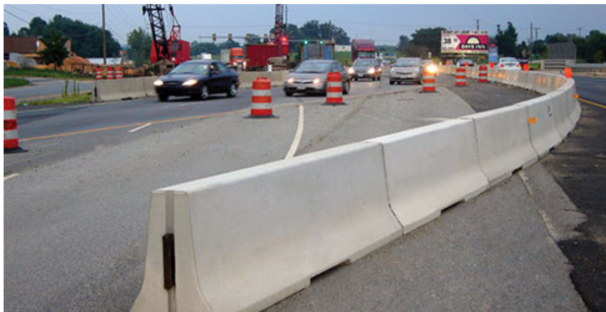
Figura 3.5 – Dispositivo de Contenção Provisória
