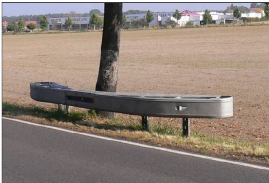
Figura 3.4 – Exemplo de Dispositivo de Contenção Pontual
