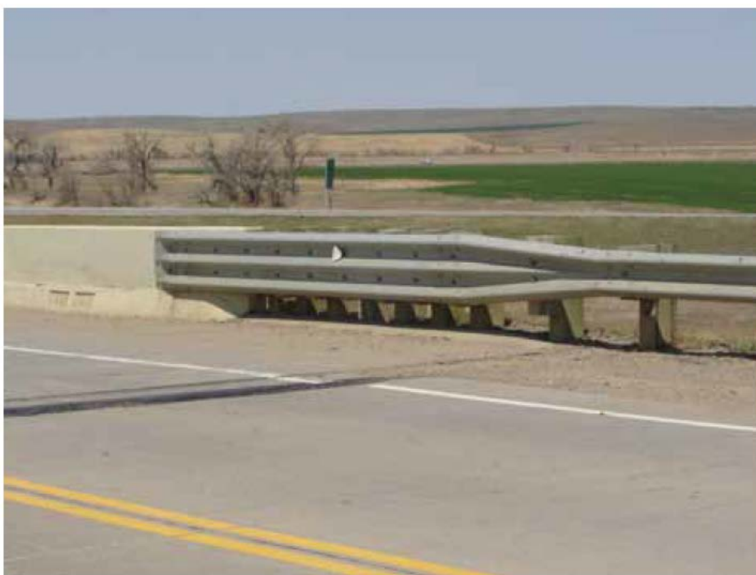
Figura 3.16 – Transição entre Defesa Metálica e Barreira Rígida
