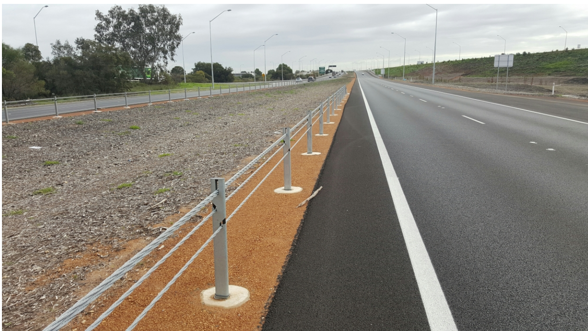
Figura 3.1 – Exemplo de Barreira de Cabo Metálico
