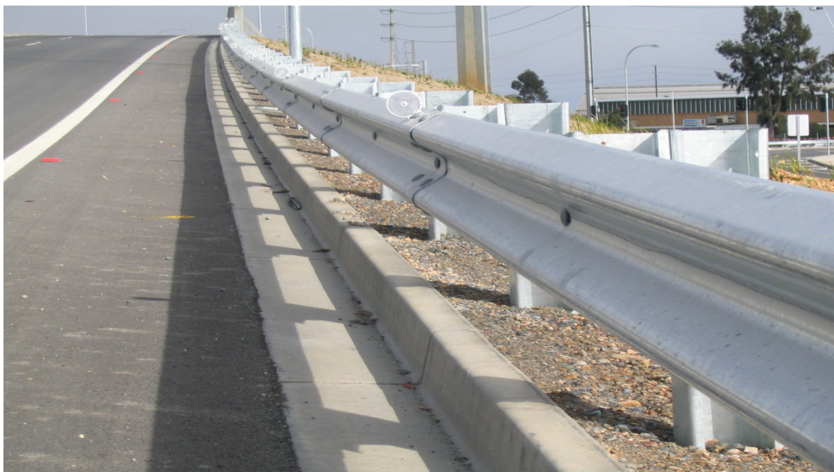
Figura 3.2 – Exemplo de Defesa Metálica
