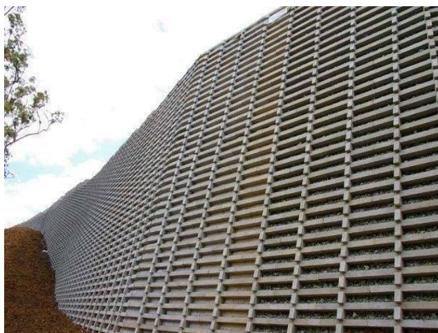
Figura 2.6 – muro de crib-wall .
