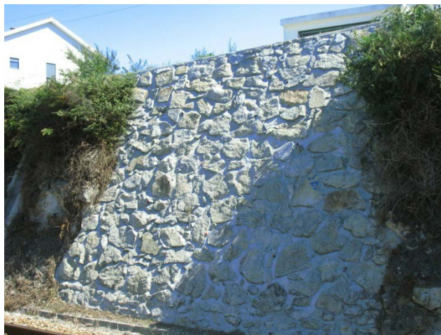
Figura 2.3 – muro de pedra argamassada. Fonte: http://www.nortejuvil.pt/page63.html
