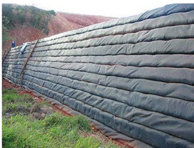
Figura 2.13 – Aterro reforçado com geotêxtil.
