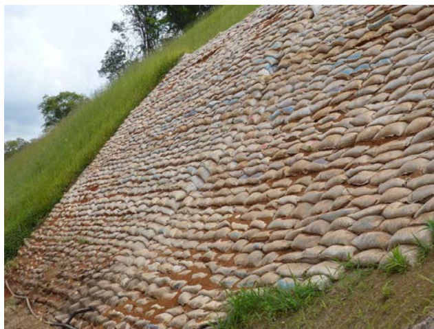
Figura 2.10 – Muro de solo-cimento.
