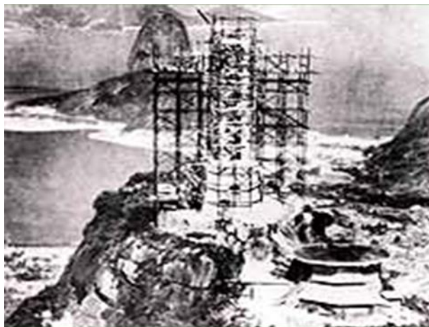
Figura 20 - Cristo Redentor em construção
