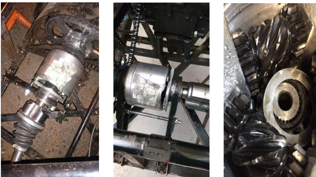
Figura 3-9: Falha catastrófica diferencial 2015 – (a), (b) e (c).
