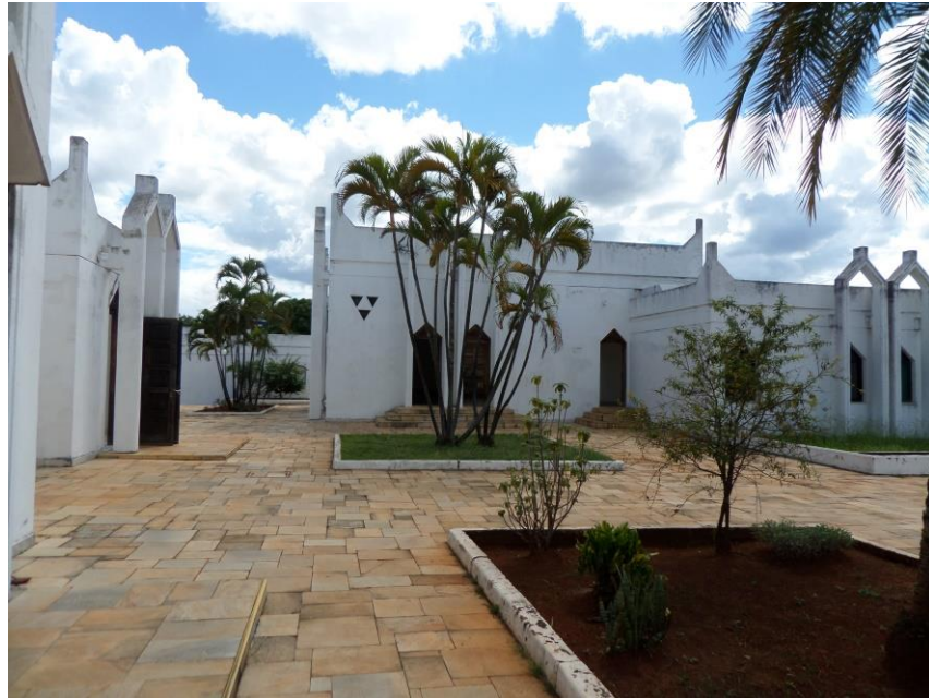
Figura 19: Área externa em frente à Mesquita do Centro Islâmico de Brasília. Fonte: LIMA, 2016.
