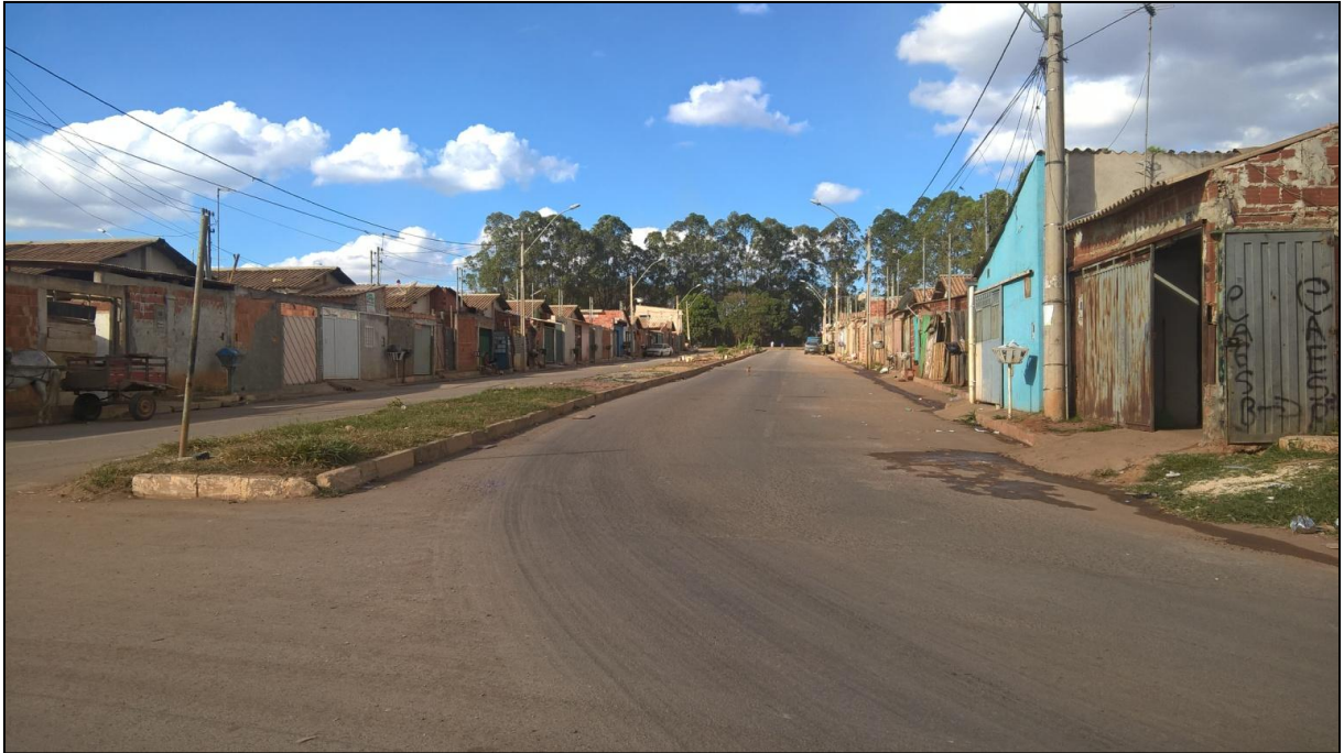
Figura 2 - Casas construídas pelo PIVE. Jéssica Mendes, junho de 2016.
