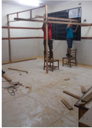
O início da construção do cenário
