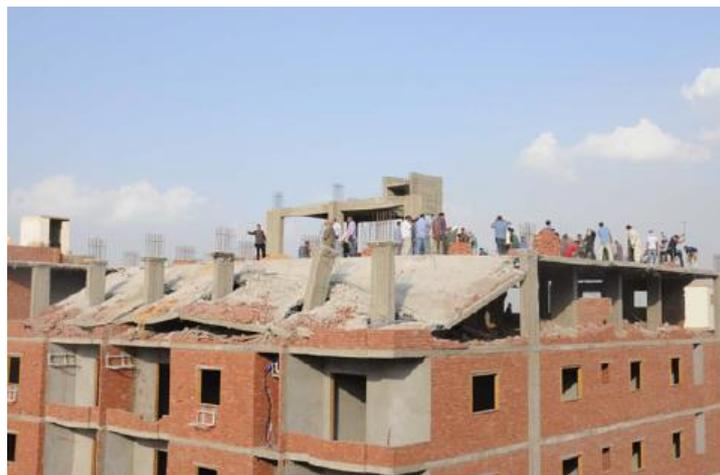
Figura 1 - Ruptura por punção em um edifício na cidade de Giza, Egito
