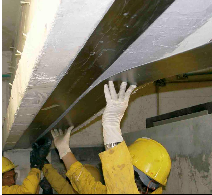
Figura 2.7 - Aplicação de lâmina pré-curada em viga de concreto
