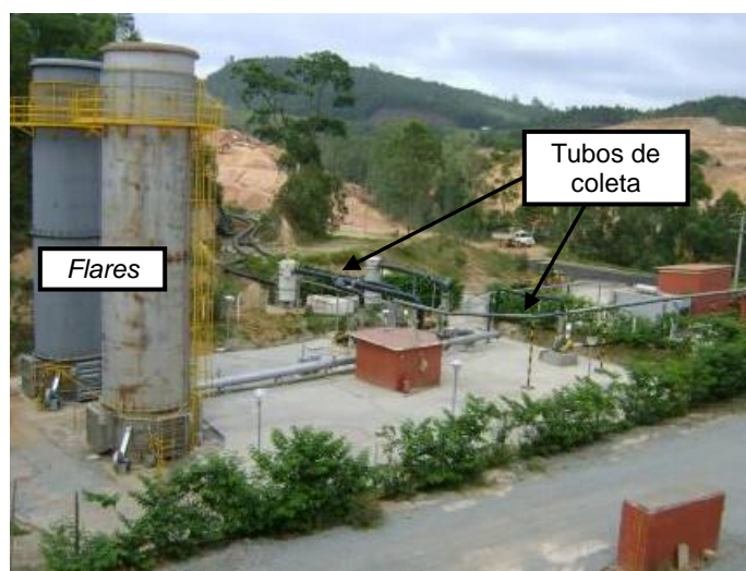
Figura 4.33 – Unidades de combustão do tipo flares do CTR – Caieiras. Modificado de Candiani e Cortez (2013).
