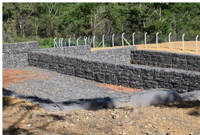
Figura 4.25 – Reservatórios de qualidade e quantidade referentes às águas drenadas superficiais e subsuperficiais na área de implantação da Etapa 1 do ASO.
