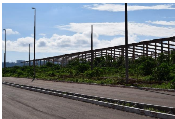
Figura 4.27 – Galpão de armazenamento de lodo da ETE Melchior, vista de uma via de acesso do ASO
