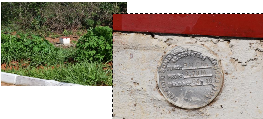
Figura 4.28 – Poço de monitoramento de jusante (PM-06) instalado em abril de 2016.
