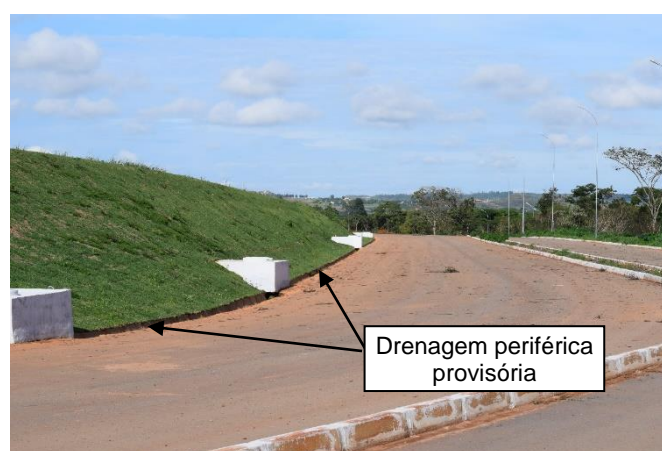
Figura 4.24 – Drenagem periférica provisória da área referente a Etapa 1 de disposição.
