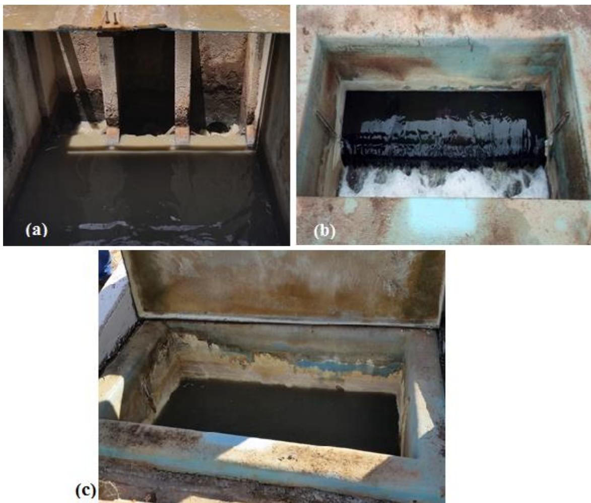
Figura 4.6 – Caixas de medição de vazão: (a) Vertedores triangulares na caixa de distribuição do ponto (1); (b) Caixa de saída com fluxo vertendo – Reator 1, lado direito, dia 04/10/2016; (c) Caixa de saída afogada - Reator 1, lado esquerdo, dia 17/10/2016.
