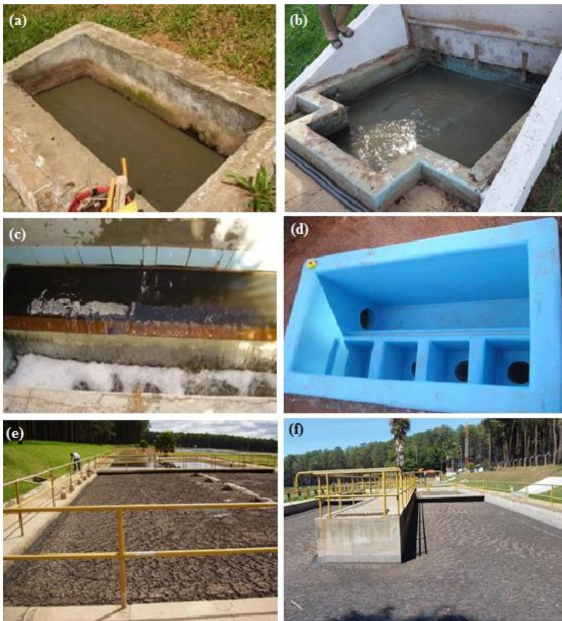
Figura 5.1 – Modificações estruturais das reformas: (a) Caixa de distribuição interna original; (b) Caixa de distribuição interna pós-reforma; (c) Caixa de saída do efluente tratado original; (d) Caixa de saída reformada com revestimento de fibra de vidro; (e) Superfície do reator original sem coleta de biogás; e (f) reator reformado com estrutura coletora de biogás.
