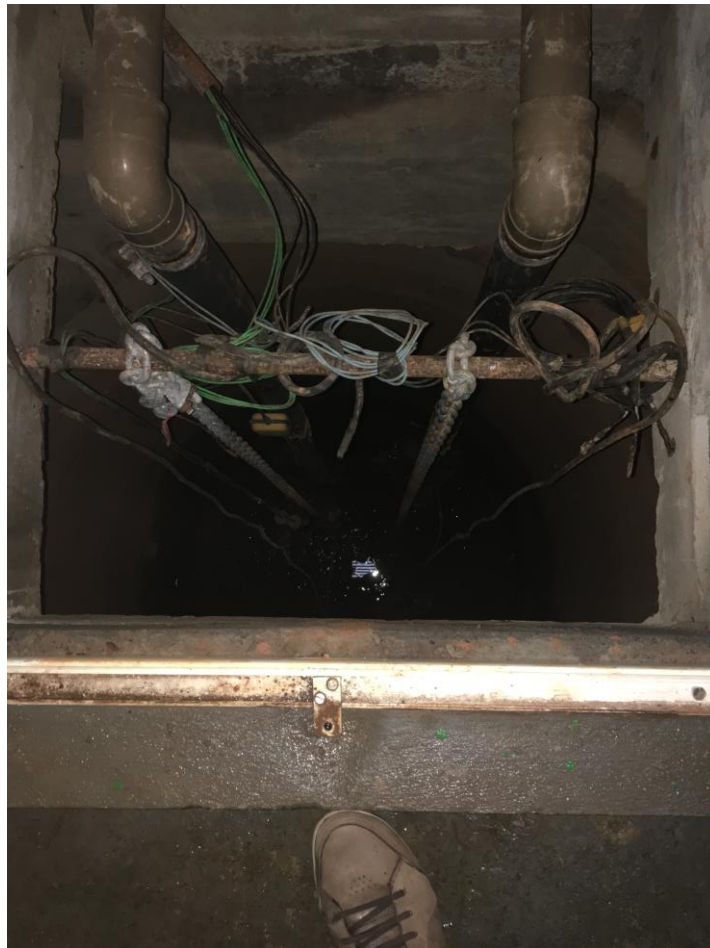
Figura 6.10 Reservatório Predial vazio.
