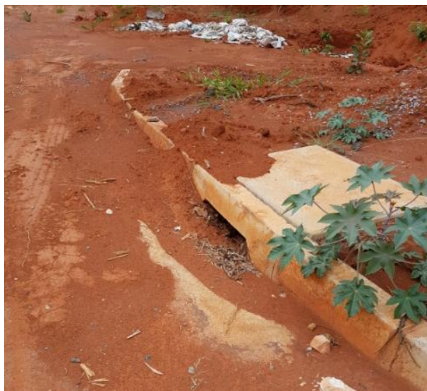
Figura 6.16 Sedimentos carreados pelas vias do Setor Noroeste.
