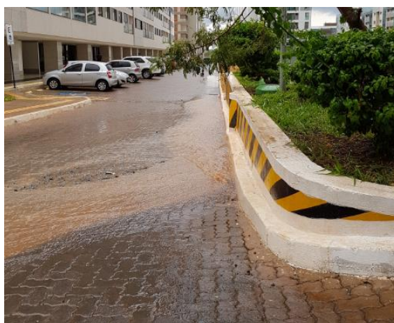
Figura 6.12 Escoamento sobre pavimento permeável no Setor Noroeste.
