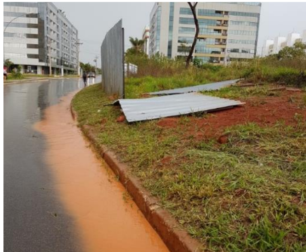
Figura 6.15 Sedimentos sendo carreados para fora de canteiro de obras no Setor Noroeste.
