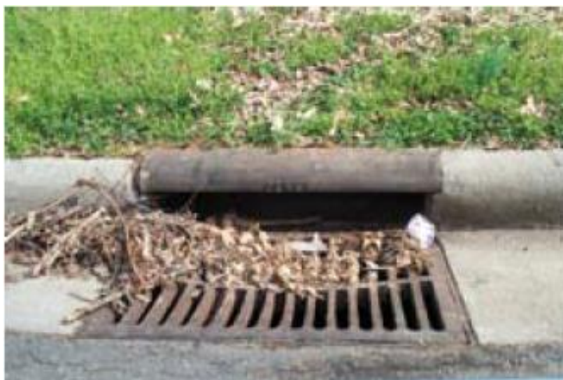
Figura 3.10 Detritos obstruindo uma boca de lobo com grelha (Fonte: Photo Book of Storm Water Features, 2006).
