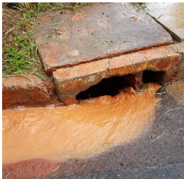
Figura 6.18 Boca de lobo recebendo sedimentos após evento de chuva no Setor Noroeste. Como pode ser observado nos mapas das Figuras 6.19 e 6.20 e como já explicitado anteriormente, o Bairro do Setor Noroeste é dividido em cinco sub-bacias. Em cada sub-bacia há uma rede de drenagem que é direcionada para uma bacia de detenção, exceto a rede da Sub-bacia 1, que é direcionada diretamente para o exutório final no Lago Paranoá. Dessa forma, as redes não são interligadas, apenas as Bacias de Detenção são interligadas.
