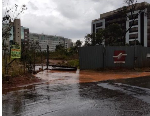
Figura 6.15 Sedimentos sendo carreados para fora de canteiro de obras no Setor Noroeste.
