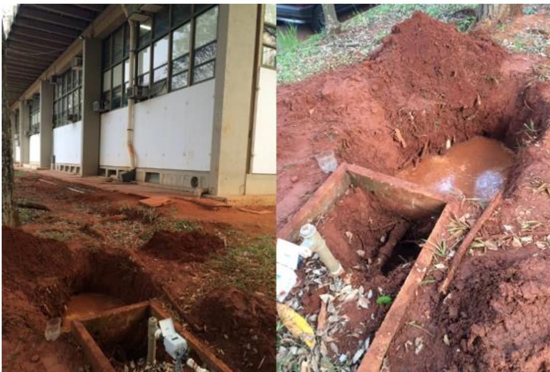
*Figura 6.2- Vazamento no SG12*
