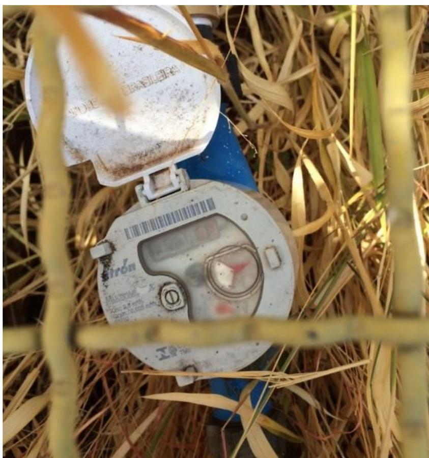
*Figura 6.1- Hidrômetro com condensação interna de umidade no vidro*
