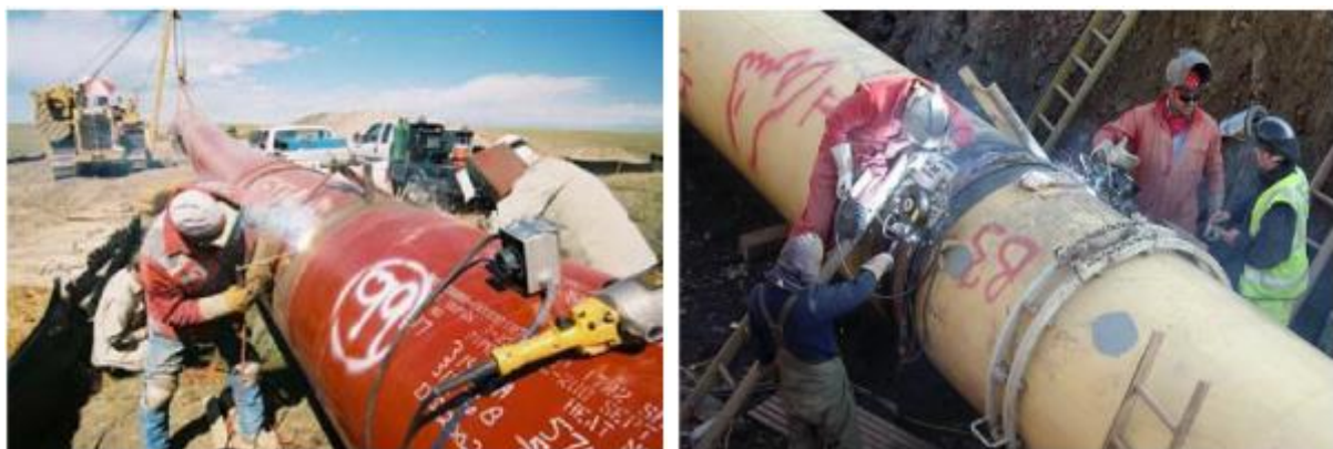
Figura 1.1. Soldagem Orbital Manual e Mecanizada [7]
