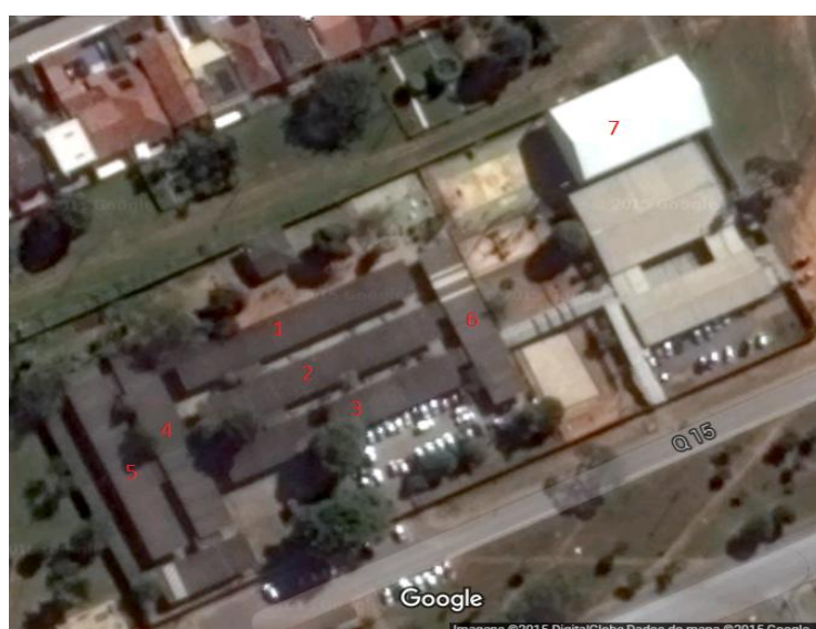
Ilustração nº 02 - Centro de Ensino Fundamental nº 04 – Sobradinho/DF – Fonte: Google Maps
