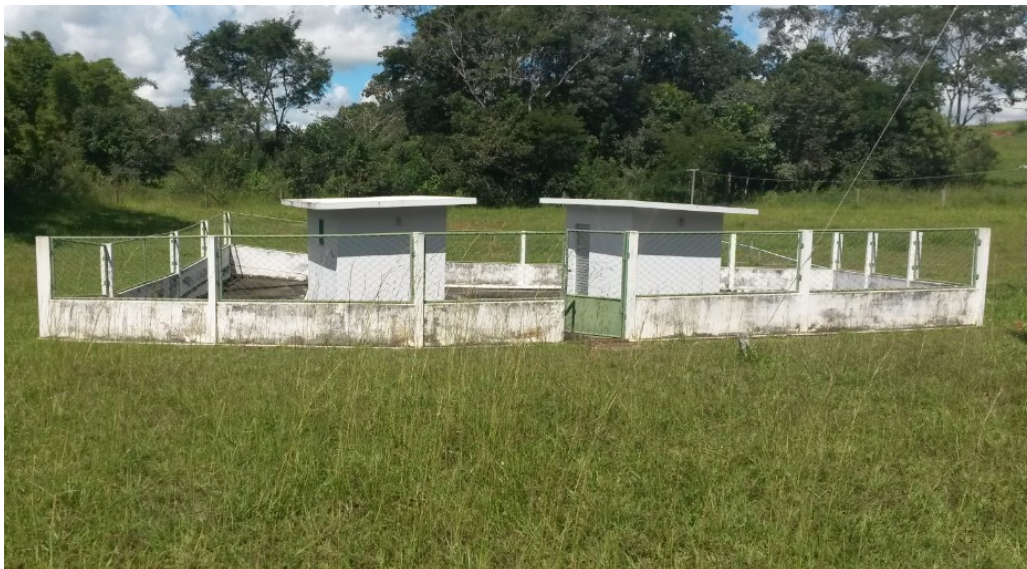
Figura 33. Vista da parte de trás de onde sairá a tubulação de recalque. Fonte:própria.
