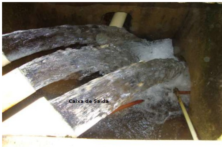
Figura 15. Caixa de saída, das fontes até o vertedouro. Fonte: própria.
