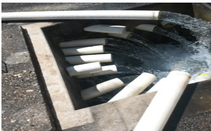
Figura 14. Caixa de passagem no interior da área cercada da captação. Fonte: própria.
