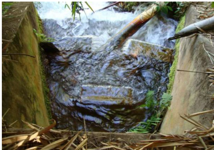
Figura 17. Vista superior do vertedouro situado na margem do Córrego Santo Antônio da Boa Vista.
