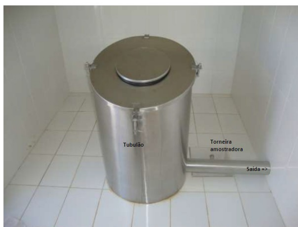
Figura 13. Tubulão instalado na captação. Fonte: própria.
