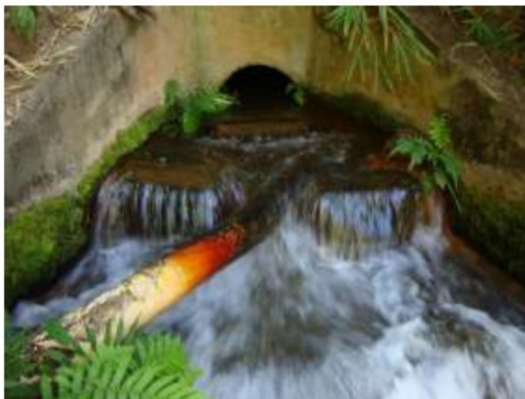
Figura 16. Vertedouro na margem do córrego Santo Antônio da Boa Vista. Fonte: própria.
