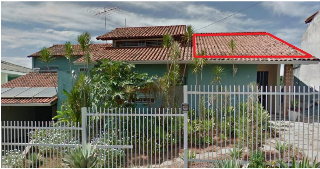
Figura 20. Área do telhado que será destinada a inserção dos módulos fotovoltaicos. Fonte: www.google.com/maps , acesso em: 30/08/2015.
