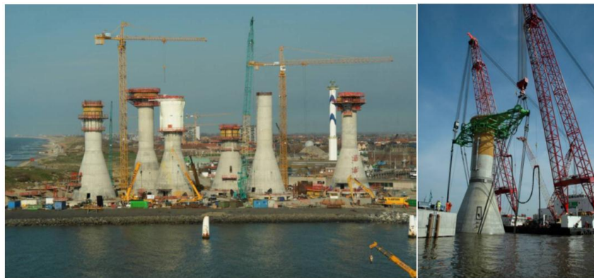
Figura 16 - Construção e instalação das bases gravitacionais. (DEWAELE, 2012)
