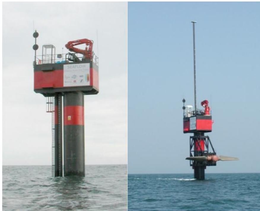
Figura 17 – A turbina Seaflow em operação e içada para manutenção ou inspeção do conjunto gerador, respectivamente. Fonte: (FRAENKEL, 2007)
