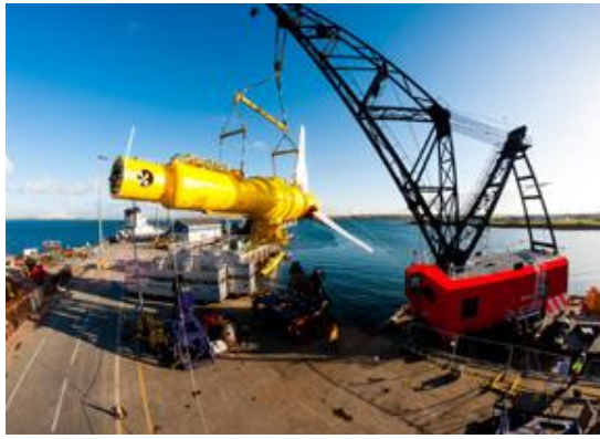
Figura 12 - Içamento da turbina Alstom. (ALSTOM, 2013)
