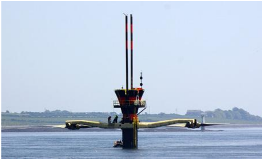
Figura 18 – A turbina SeaGen S içada para manutenção. (JHA, 2008)
