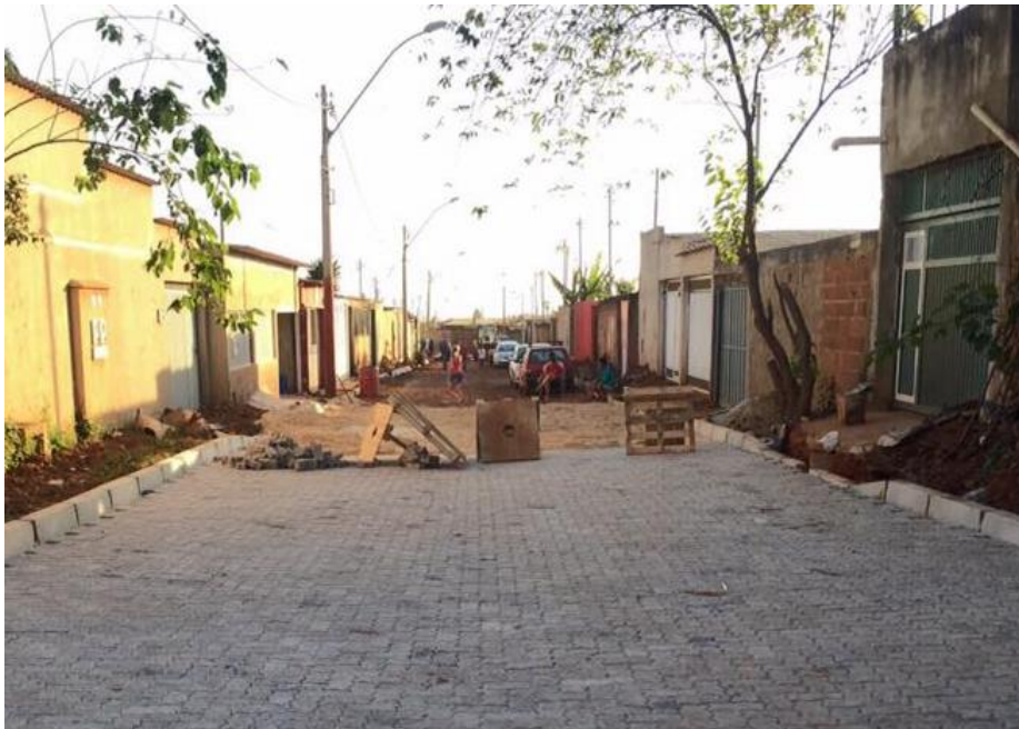
[Figura 10. Pavimentação de via em Sol Nascente]
