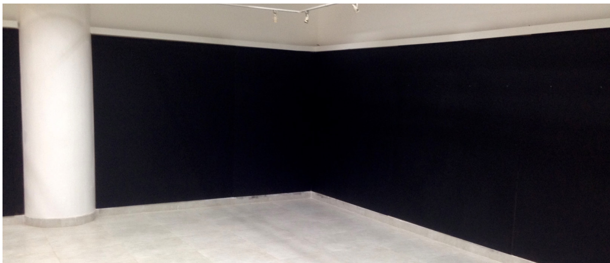
Figura 20 - Pintura interna da galeria
