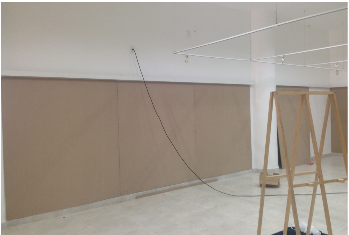
Figura 11 - Espaço Sesc 504 Sul, fixação das placas de MDF na parede
