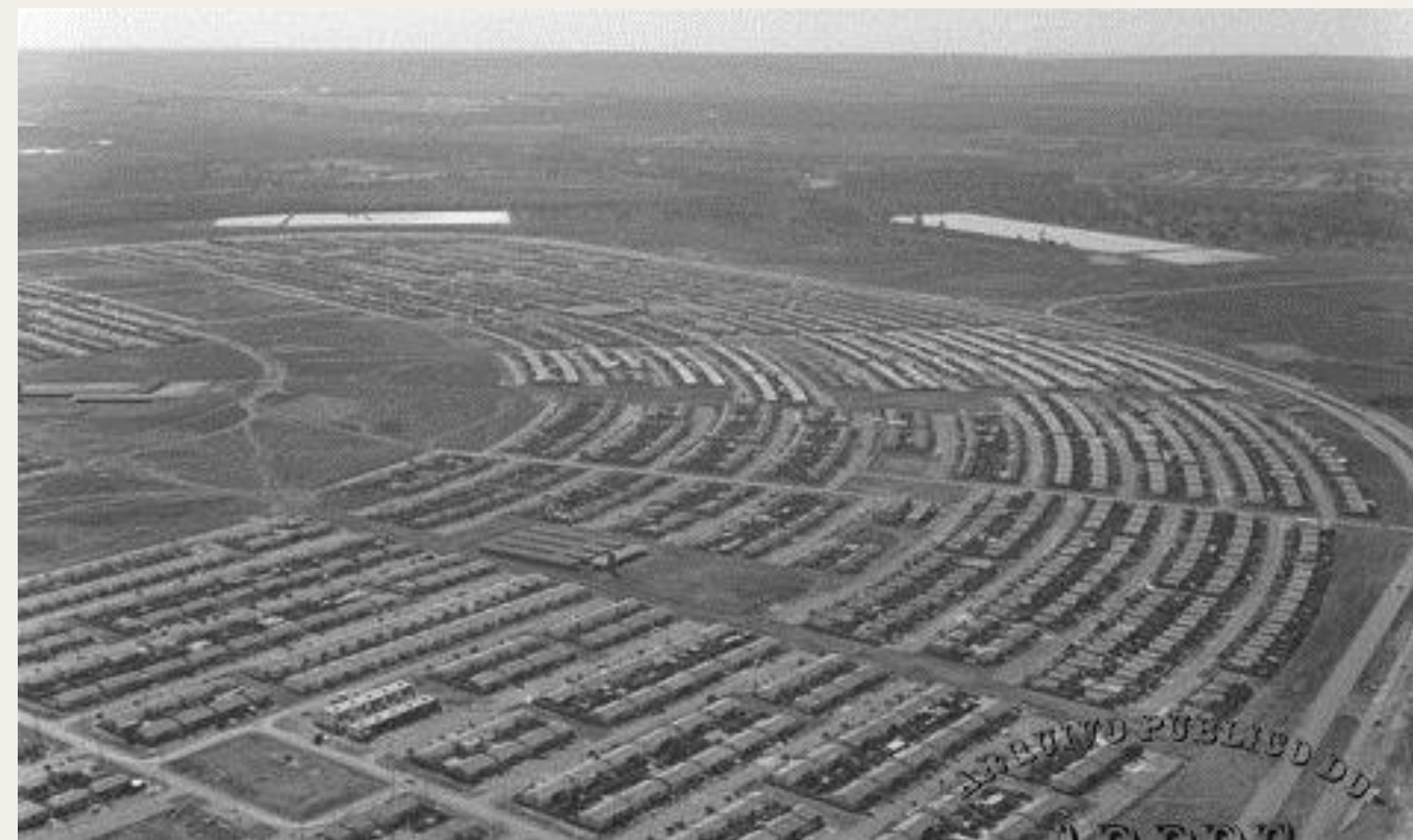
Foto Aérea do Guar4 II no início de sua construção Fonte: Novacap.
