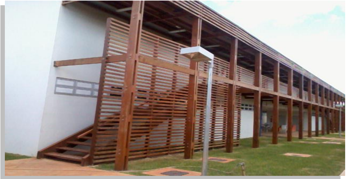
Foto (5). Fachada externa do prédio do alojamento da LEdoC . (acervo da autora).
