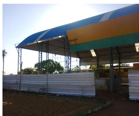
Fig.2. Quadra depois da cobertura
