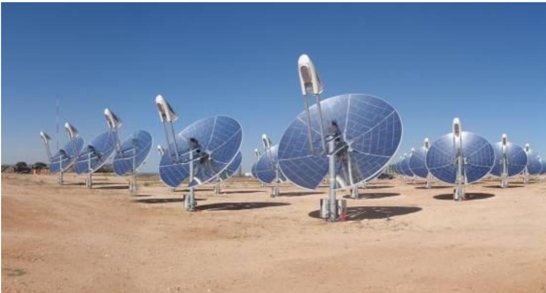
Figura 15- Sistema de Disco Parabólico. Fonte: Helionotícias, disponível em <<http://www.helionoticias.es/b3.php>> Acesso em maio 2014.
