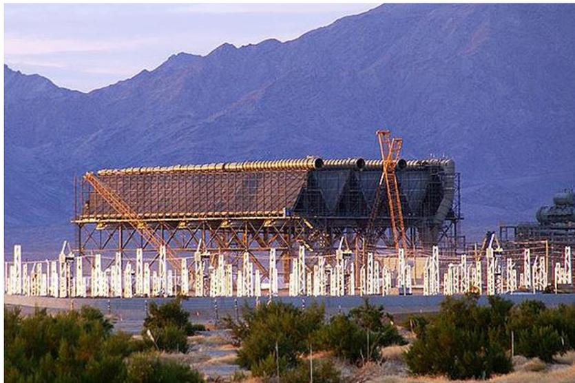
Figura 21 - Sistema direto ACC da heliotérmica Genesis Solar Energy Project, localizada nos Estados Unidos. Fonte: National Renewable Energy Laboratory, disponível em <[http://www.nrel.gov/csp/solarpaces/project\\_detail.cfm/projectID=54](http://www.nrel.gov/csp/solarpaces/project_detail.cfm/projectID=54)>. Acesso em novembro 2014.
